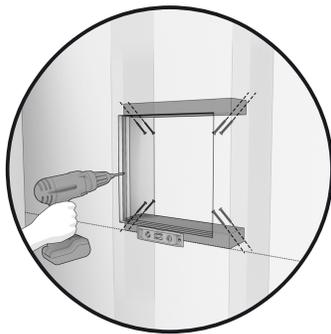
3. Mettre à niveau et fixer le cadre de soutien supérieur et inférieur aux montants verticaux adjacents.
